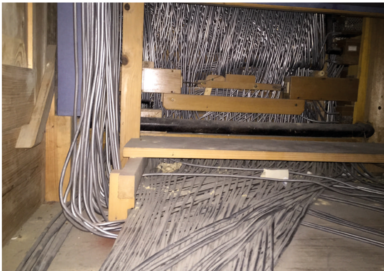
Naraksove Orgle v Špitaliču – Povezava igralnika z orglami z uporabo pnevmatskega sistema, ki pošilja zrak po svinčenih cevkah
