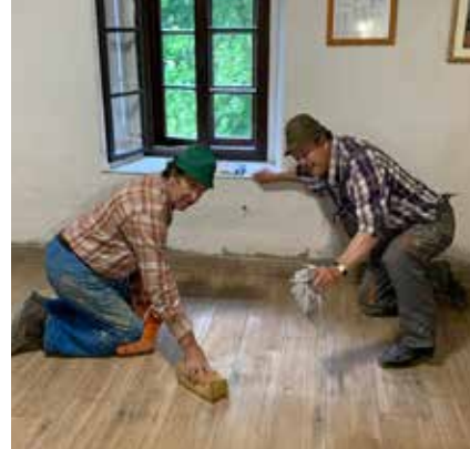
Zaključna obnovitvena dela v stari šoli: polaganje ploščic – Joža in Tone
